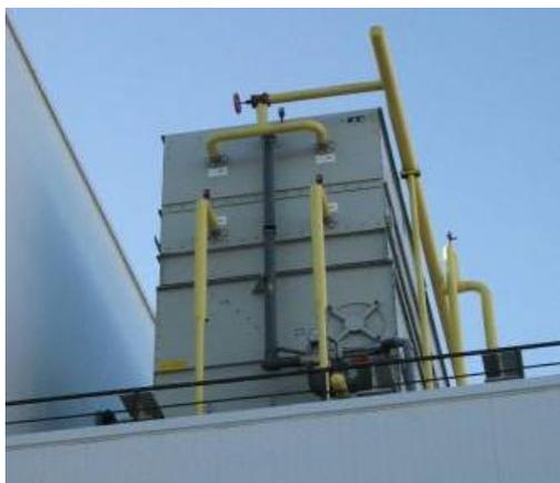
Ilustración 20 – Condensador evaporativo
