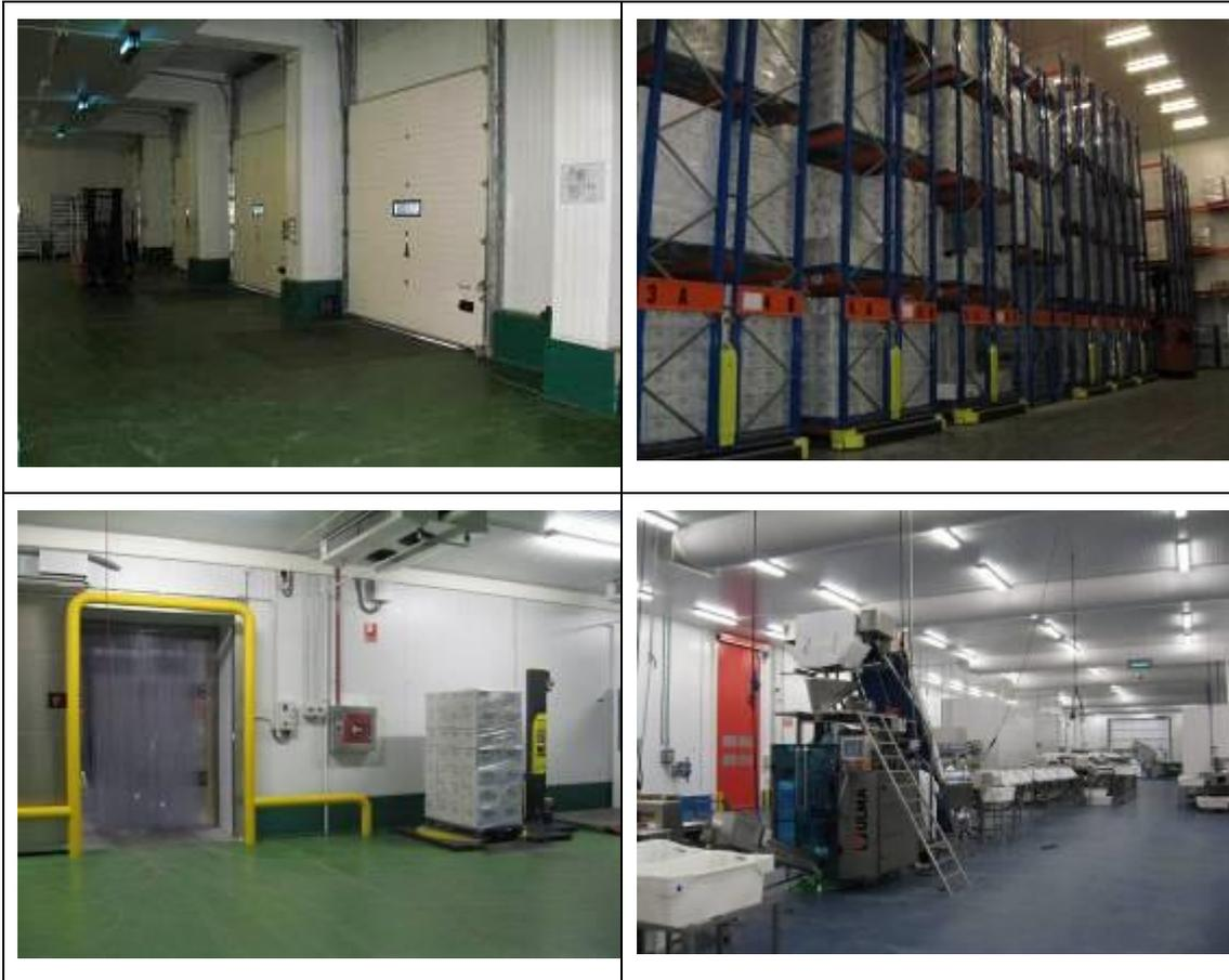
*Ilustración 5 – Instalaciones. De izquierda a derecha y de arriba abajo: antecámara, almacén frigorífico, exclusión neumática y sala de elaboración*
